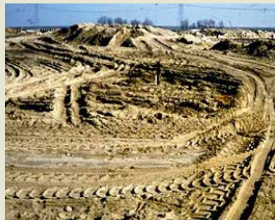
▲ Eerste stadium van het bouwrijp maken
