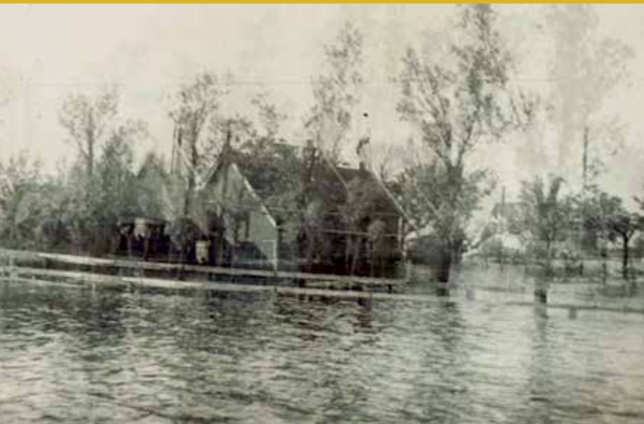
Onderwaterzetting Keverdijkse polder ter hoogte boerderij Keverdijk 18
