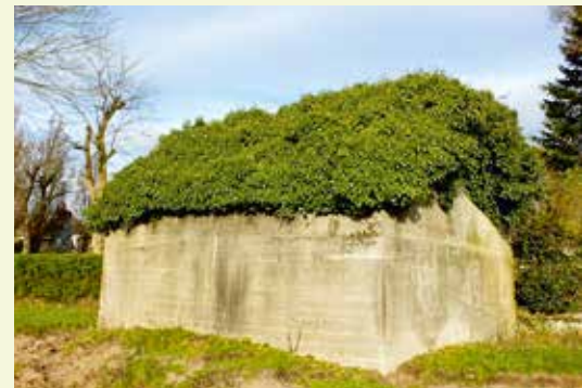
Groepsschuilplaats/bunker HM68 Paulinalaan
